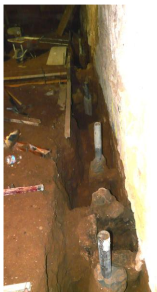
Foto 34. Sector 1. Trava 2. Tram inicial.
