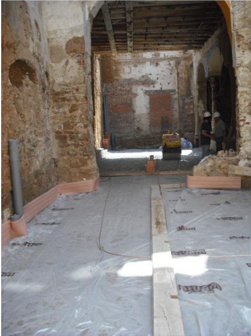
ULTIM RECOBRIMENT AMB MORTER PROTEGINT LES TROBADES AMB ELS MURS
