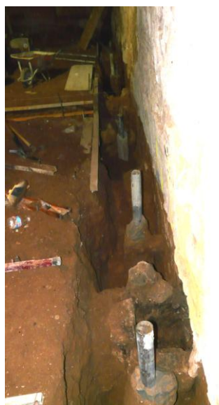
Foto 34. Sector 1. Trava 2. Tram inicial.
