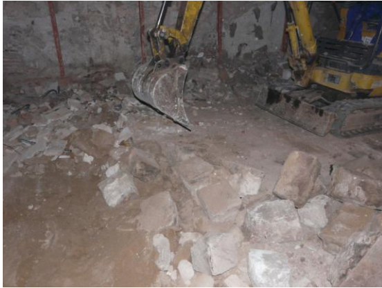
Foto 1. Aixecament, de forma mecànica del paviment de llambordes al sector 2. Des del NO.
