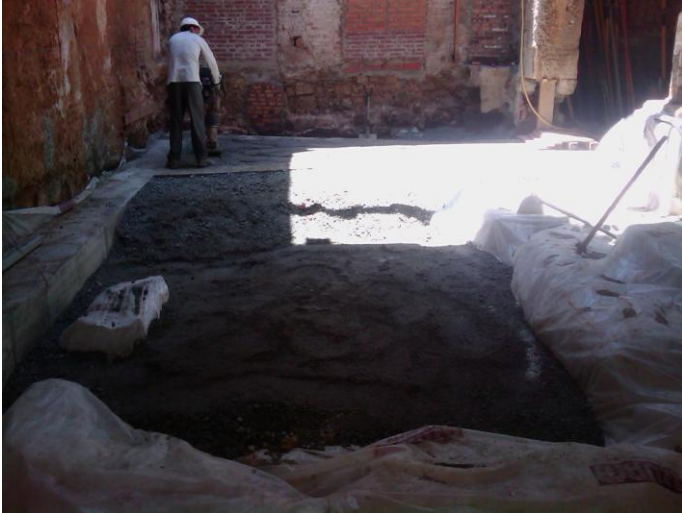
PROTECCIO AMB GEOTEXTIL I REPLE AMB GRAVA
