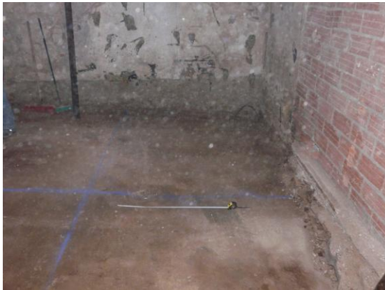
Foto 2. Vista inicial de l'espai on es va excavar el fossat d'ascensor. Vista des del SE.
