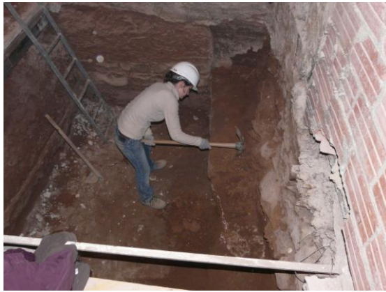
Foto 9. Fossat d'ascensor. Desmuntatge parcial UE 8.
