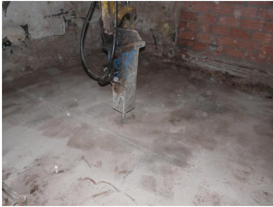
Foto 3. Sector 1. Excavació, de forma mecànica de la UE 1 Des del S.
