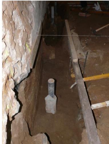
Foto 35. Sector 1. Trava 2. Tram central.
