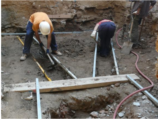
Foto 17. Sector 2, Excavació rases 3 i 4.
