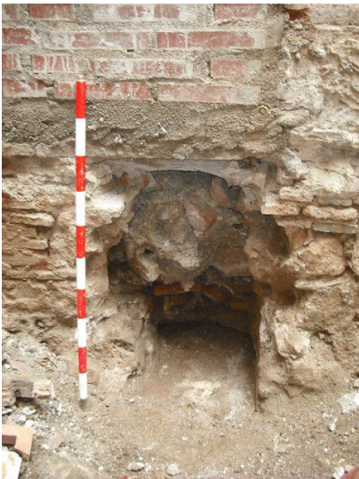
UE 8 AFECTADA PER ARQUETA CLAVEGUERA
