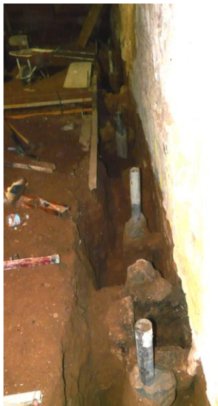
Foto 34. Sector 1. Trava 2. Tram inicial.
