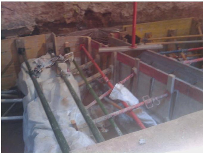
IMATGE DE REALITZACIO DE RIOSTRES PROTEGINT LES RESTES
