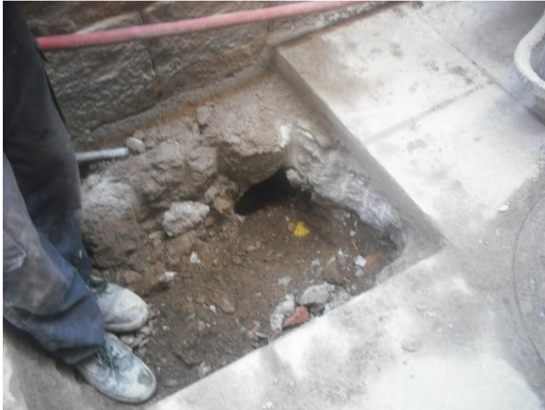
UE 82 AFECTADA PER ARQUETA CLAVEGUERA
