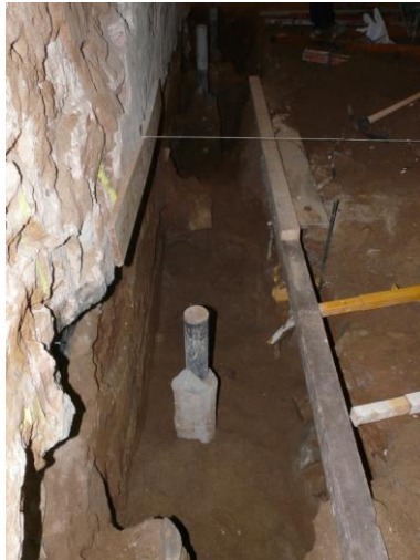
Foto 35. Sector 1. Trava 2. Tram central.
