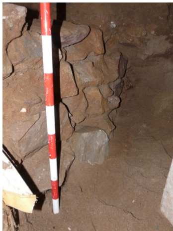
Foto 102. Sector 2. Vista de la cara SE del mur UE 114.
