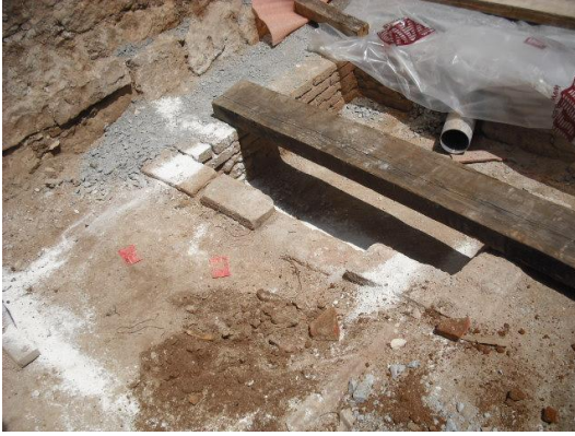
UE 82 AFECTADA PER ARQUETA DE CLAVEGUERA
