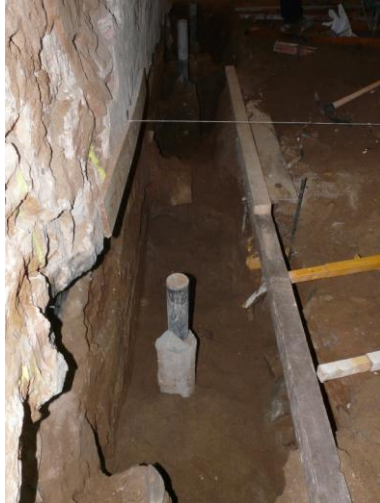
Foto 35. Sector 1. Trava 2. Tram central.
